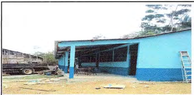
Foto 5: Colocación de puerta
