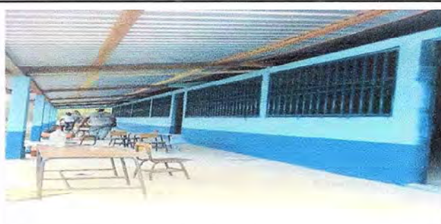
Foto 4: Colocación de balcones
