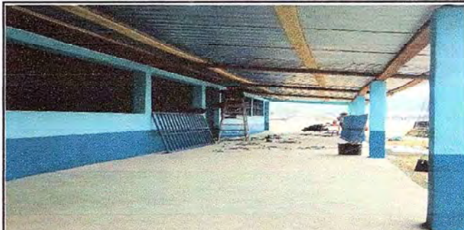
Foto 2: Corredor de la Escuela
