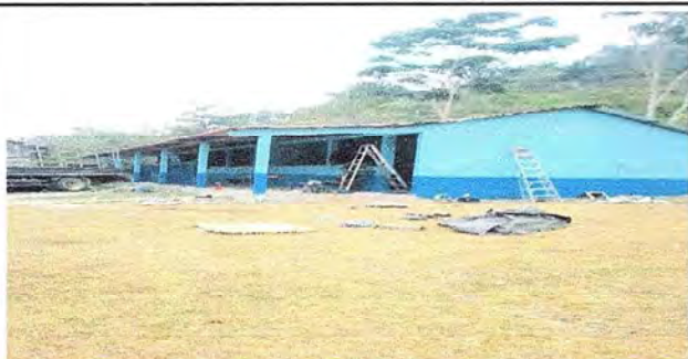
Foto 1: Finalización del trabajo.
